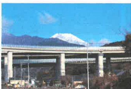
⑩新東名高架橋
