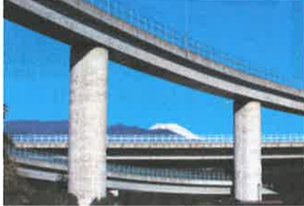
⑪新東名高架橋
