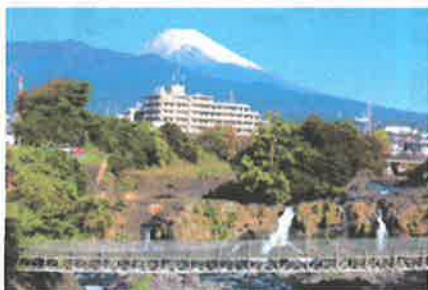
⑦鮎壺の滝吊り橋
